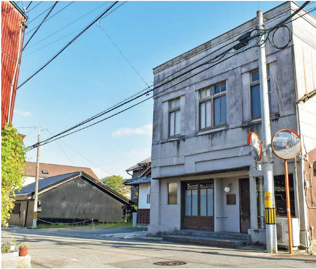
▲カフェとなって現存している建物(旧太田郵便局)
