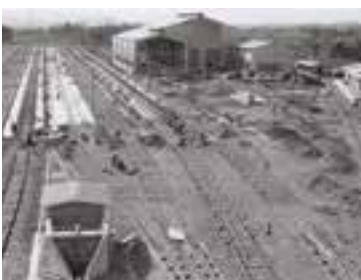
▲建設中のディーゼル基地(昭和40年)
